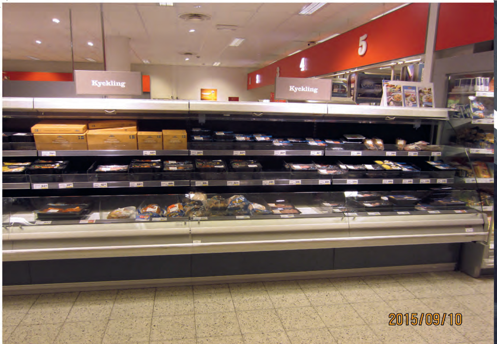
Figur 4 Demonstrationen gjordes i ändsektionen av en treplans kyldisk som består av flera sektioner som kyls med var sitt kylbatteri.
