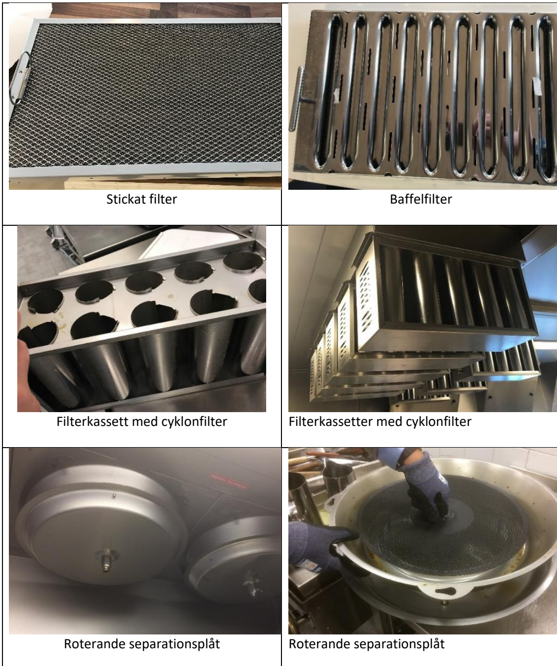
Figur 1: olika typer av mekaniska filter
