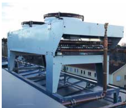
Figur 1: Vanligtvis fläktas värme från kylsystemet bort via uteluften med kondensorer.
