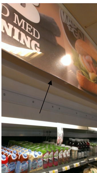
Bild 9 Pilen i bilden visar placering av logger för lufttemperatur och luftfukthalt i butiken.
