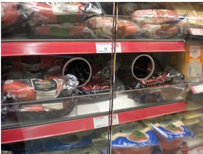
Figur 6 Butiken valde att montera enkelglasdörrar utan karm och handtag.
