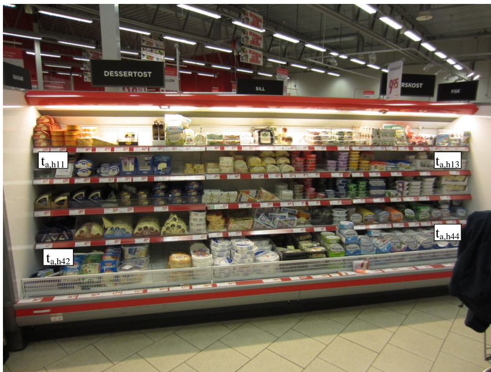
Figur 18 Temperaturgivarnas positioner i kyldisk K15.
