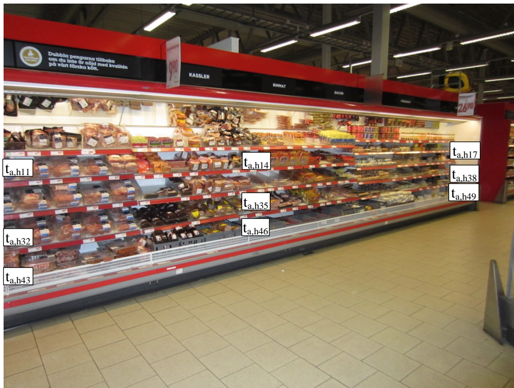
Figur 17 Temperaturgivarnas positioner i kyldisk K27.
